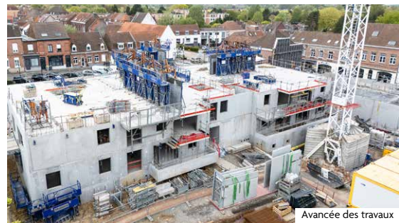
Avancée des travaux
